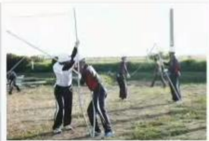
台風で倒壊したビニールハウスの撤去
