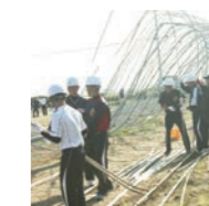
台風で破損したビニールハウスの撤去をサポート(2018年度)
